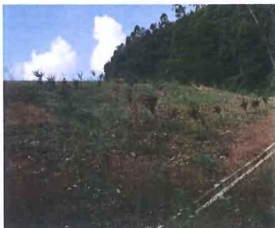
排土场排水沟
