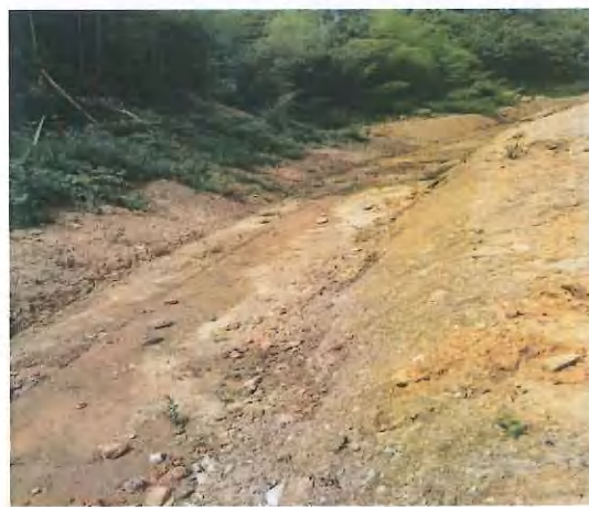
采场临时排水沟
