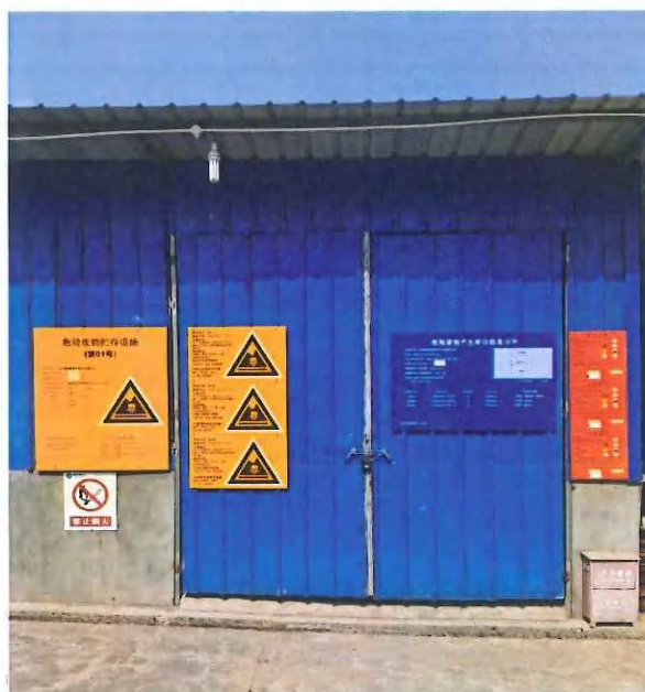
危废暂存间照片
