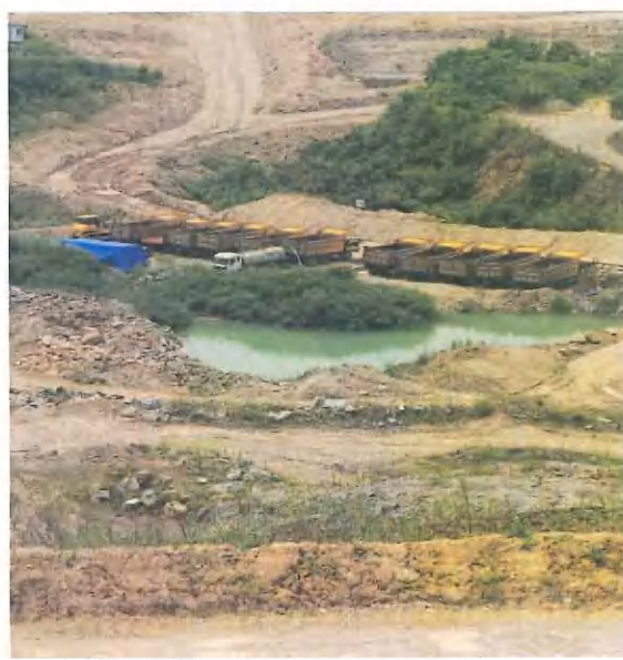
初期雨水沉淀池
